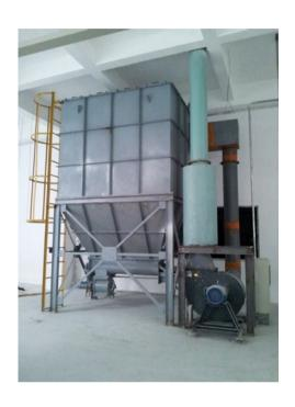
含尘气体进入除尘器后,由于气流断面突然扩大及气流分布板作用,气流中一部分粗大颗粒在动和惯性力作用下沉降在灰斗; 粒度细、密度小的尘粒则进入滤尘室,通过布朗扩散和筛滤等组合效应,使粉尘沉积在滤料表面上。阻力达到某一规定值时,电磁脉冲阀自动开启,压缩空气在上箱体内迅速膨胀,涌入滤袋,使滤袋膨胀产生振动,并在逆向气流冲刷的作用下,吸附在滤袋外表面上的粉尘被剥离落入灰斗中。净化后的气体进入净气室由排气管经风机排出。
