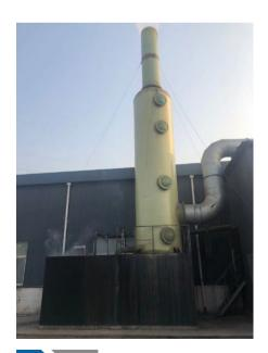
我公司自主生产的烟气脱硫脱硝塔主要用于窑炉烟气脱硫脱硝, 产品以玻璃钢为主要材质,经过喷淋悬流+尿素液湿法脱硝+湿 法脱硫工艺,将烟气中的氮氧化物、二氧化硫进行中和处理,从 而降低排放浓度,达标排放。
